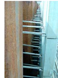
Einbau der Sohl-befestigung in der Bootsgasse
