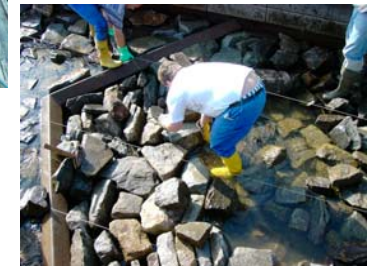
Einbau der Sohl-befestigung in der Bootsgasse
