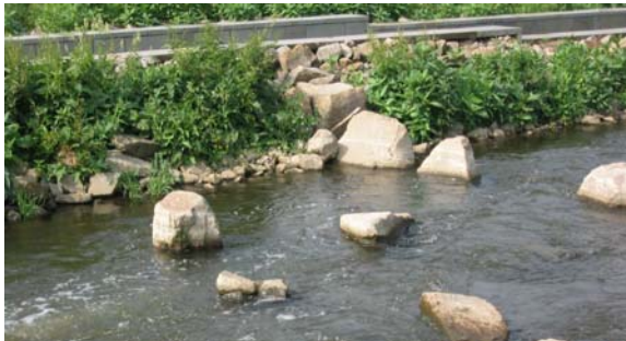
Hinter den großen Störsteinen im Fischpass befinden sich strömungsberuhigte Bereiche in denen sich Fische ausruhen können
