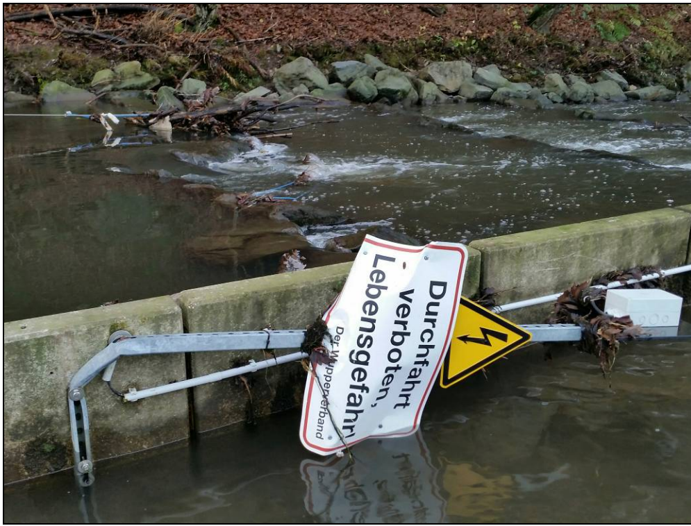
Abb. 22: Vom Hochwasser im Dezember 2015 umgeknickter Ständer, der nicht nur diverse Gefahrenschilder trug, sondern auch die Tunerboxen für Antenne 14 am Auer Kotten (Foto: Wupperverband)
