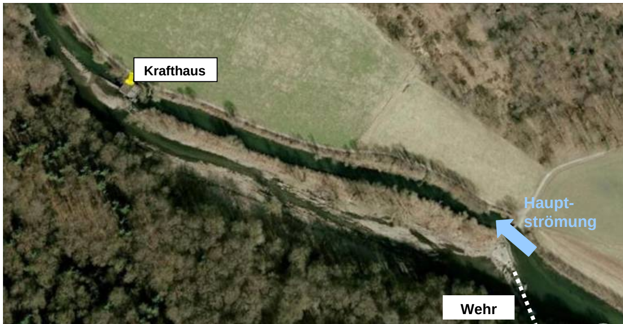
Abb. 58: Die Hauptströmung der Wupper fließt dem Krafthaus zu, während das Ausleitungswehr mit dem Raugerinne abseits davon liegen (Luftbild: Google Earth)
