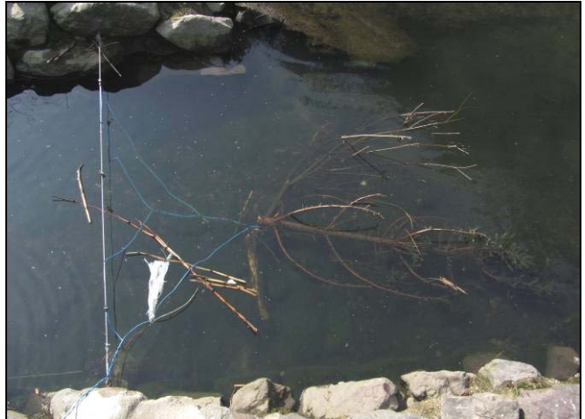
Abb. 17: Durch Treibgut zerstörte Antenne 5 im Leerschuss des Auer Kotten
