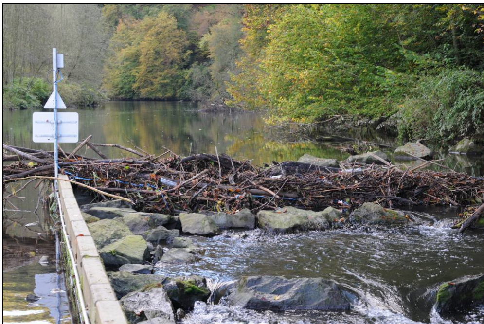
Abb. 23: Treibgutstau vor dem Fangeseil stromauf von Antenne 14 am Auer Kotten
