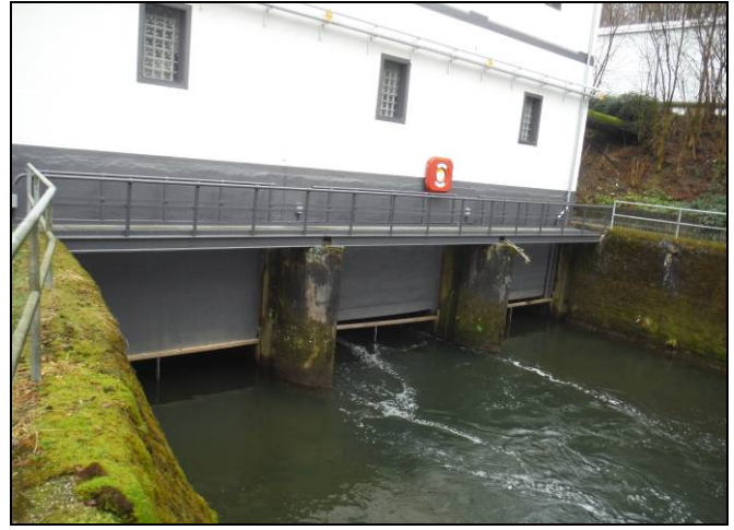
Abb. 5: Die HDX-Antennen 21 bis 23 an den Turbinenausläufen; mittlere Turbine in Betrieb
