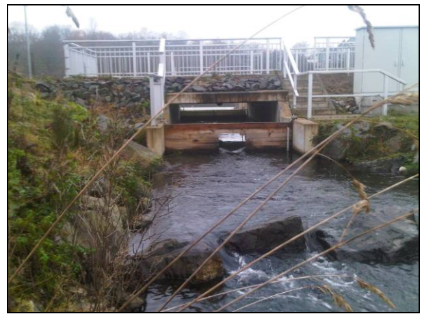
Abb. 15: Einlaufbauwerk der Fischaufstiegsanlage mit Antenne 52
