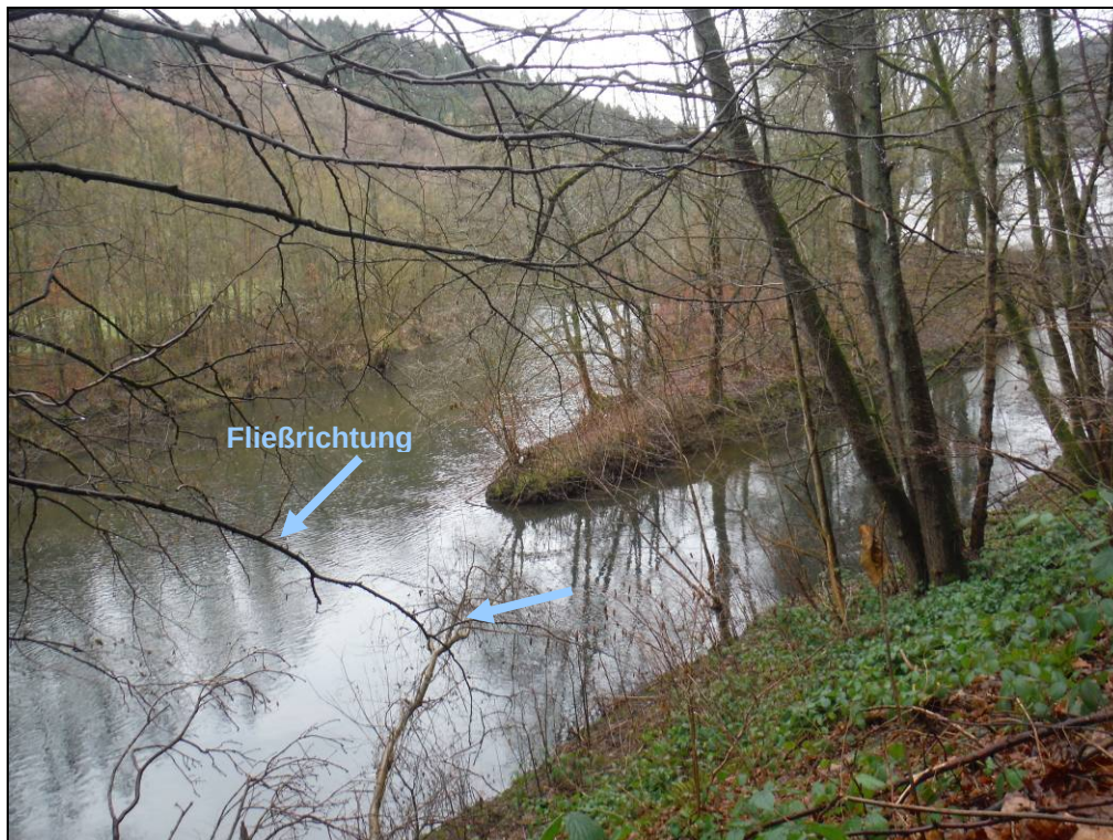
Abb. 44: Zusammenfluss des Mutterbetts (links) und des Turbinenunterwassergrabens (rechts) zum Krafthaus des Wasserkraftwerks Glüder
