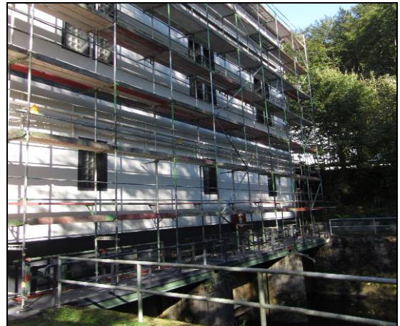
Abb. 19: Seit Sanierungsarbeiten am und im Krafthaus Glüder funktioniert die Kommunikation der Antennen 21 bis 23 mit dem PC nicht mehr
