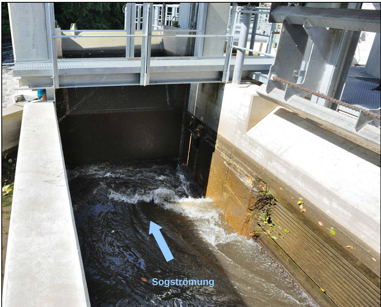
Abb. 59: Die bei der Öffnung des Spülschütz entstehende Sogströmung reißt nicht nur Treibgut und Geschwemmsel mit sich vom Rechen fort, sondern auch Fische, die sich vor der unpassierbaren Barriere aufhalten
