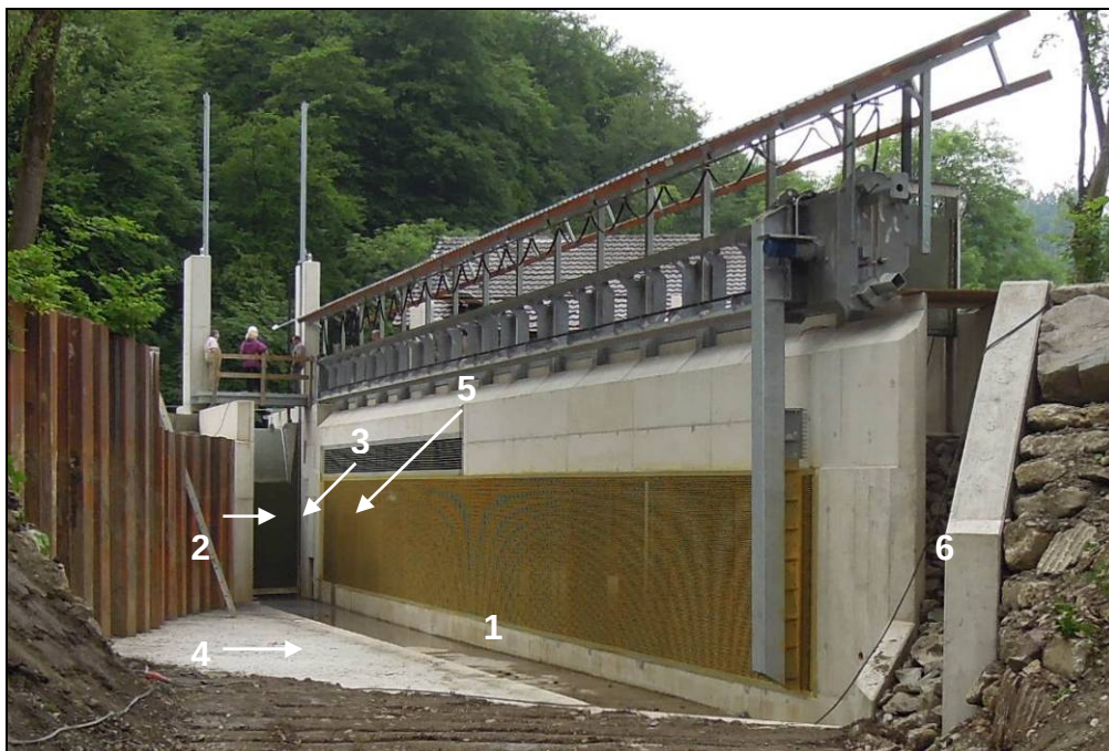
Abb. 52: Modell für die Einbauten in der ethohydraulischen Laborrinne standen die Fischschutz und -abstiegseinrichtung am Turbineneinlauf des Auer Kotten mit dem 1) schräg zur Anströmung gestellten 12 mm-Horizontalrechen, 2) das Spülschütz zur Abführung des Rechengutes ins Mutterbett, 3) der oberflächennahe und 4) der sohlennahe Bypass, 5) der Smoltbypass über dem Turbineneinlauf und 6) der Einlauf in den Schlitzpass am oberstromigen Ende des Rechens (Foto: Ingenieurbüro Floeckmühle)
