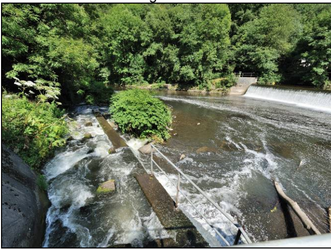
Abb. 6: Der hydraulisch meist stark überlastete Raugerinnebeckenpass mündet gewandelt ins Unterwasser des Wehres
