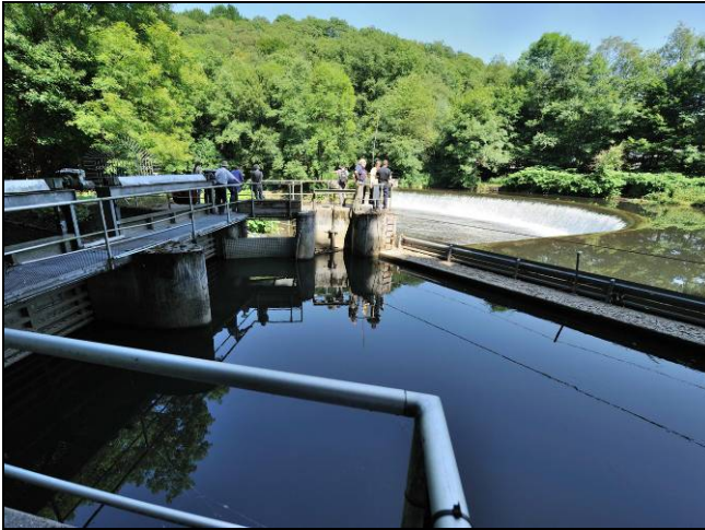
Abb. 4: Bogenförmiges Ausleitungswehr, im Vordergrund zweigt der sehr lange Turbinenobergraben zum Krafthaus ab
