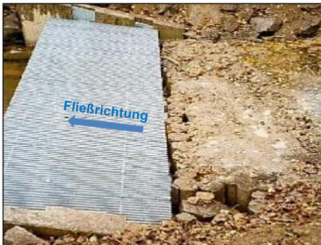
Abb. 19: In Fließrichtung ansteigendes Tiroler Wehr (Foto: [www.floecksmuehle.com/img/e23fbee9fb9accd6.pdf](http://www.floecksmuehle.com/img/e23fbee9fb9accd6.pdf) / November 2013)
