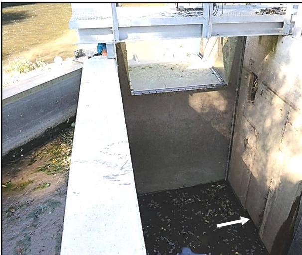
Abb. 70: Nur noch die Oberkante des sohlen-nahen Bypasses überragt das ange-landete Sediment; Aufnahme bei gelenztem Turbinenobergraben (Foto: Institut für angewandte Ökologie)
