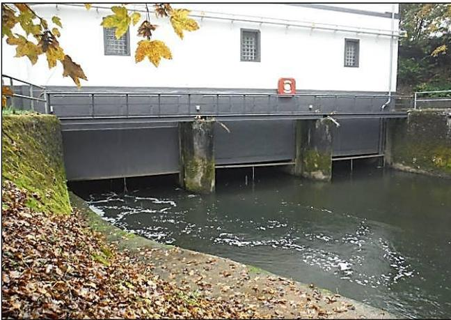
Abb. 27: Unterwasseransicht des Krafthauses mit laufender Turbine und drei HDX-Antennen (Foto: Institut für angewandte Ökologie)
