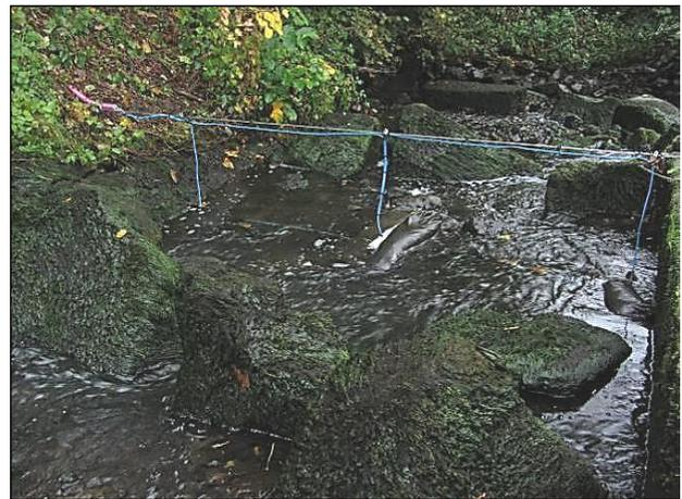
Abb. 30: HDX-Seilantenne Nr. 24 im mittleren Abschnitt der Fischaufstiegsanlage (Foto: Institut für angewandte Ökologie)
