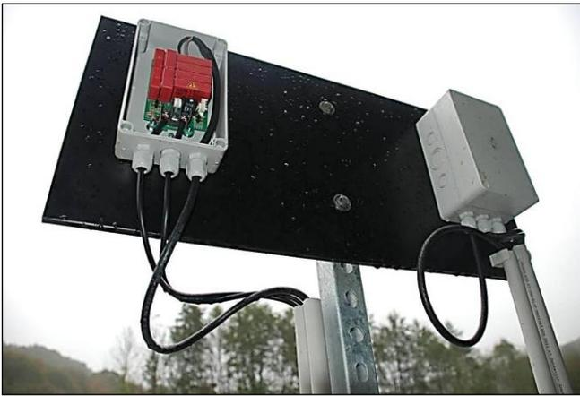
Abb. 10: Hochwassersicher aufgeständerte Tunerboxen; links mit geöffnetem Deckel (Foto: Institut für angewandte Ökologie)
