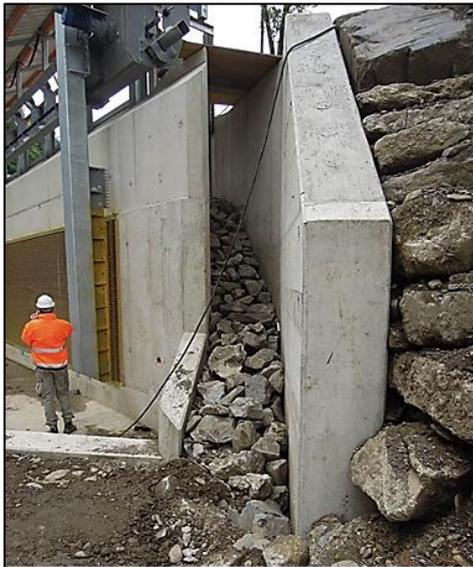
Abb. 24: Einlauf in den Schlitzpass während dem Bau (Foto: Ingenieurbüro Floecksmühle GmbH)
