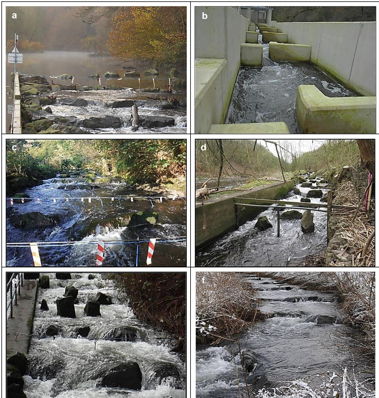
Abb. 65: Strömungscharakteristik im a) Raugerinne-Beckenpass und b) Schlitzpass am Auer Kotten, c) Fischrampe in Riegelbauweise am Schaltkotten, d) Umgehungsgerinne in Riegelbauweise in Buchenhofen, e) Raugerinne-Beckenpass in Glüder, f) Umgehungsgerinne in Riegelbauweise am Beyenburger Stausee (Fotos: Institut für angewandte Ökologie)
