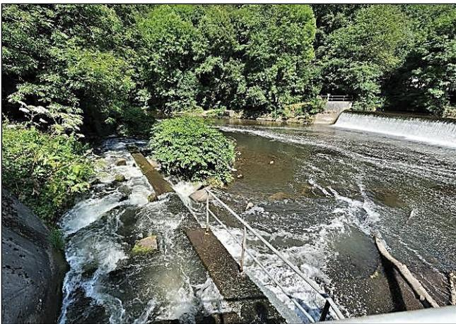
Abb. 29: Hydraulisch überlasteter Raugerinne-Beckenpass (links), der gewandelt ins Unterwasser des Ausleitungswehres mündet (Foto: Institut für angewandte Ökologie)
