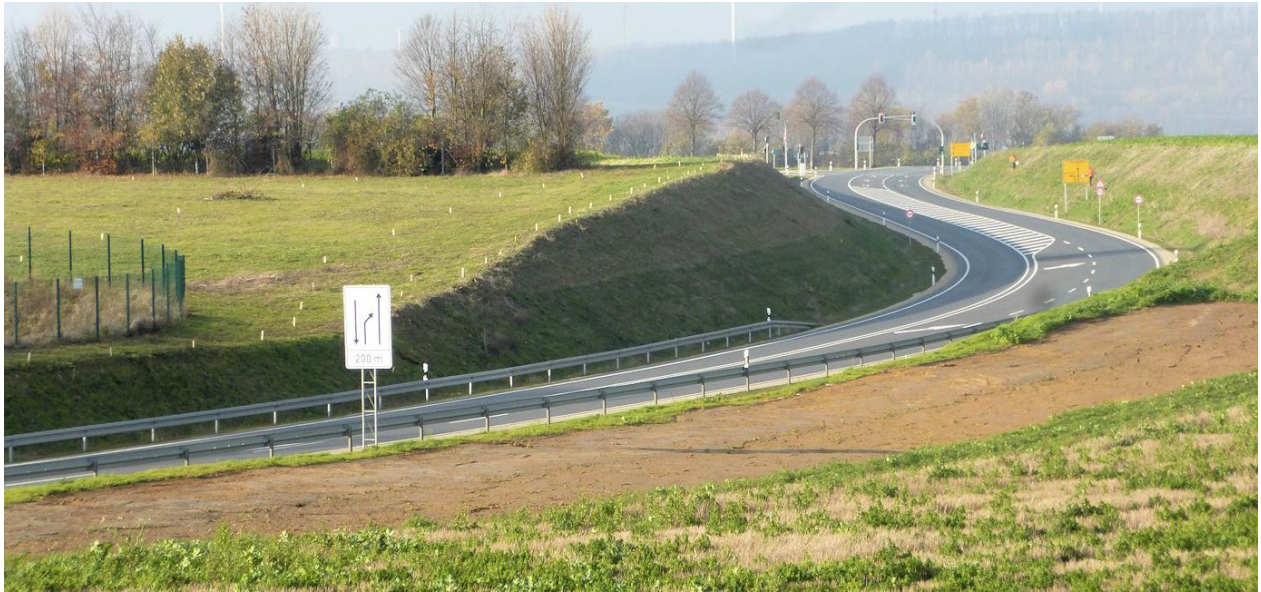
Abb. 1: Neue Trasse mit Blickrichtung nach Grevenbroich
