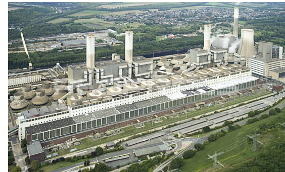
Folgenutzung Kraftwerk Frimmersdorf
