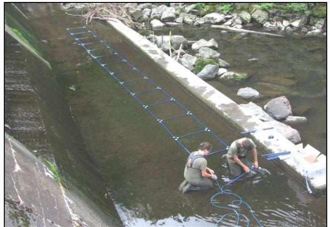
Abb. 18: Montage der „schwimm drüber“-Antenne in Strickleiterbauweise für das Mutterbett
