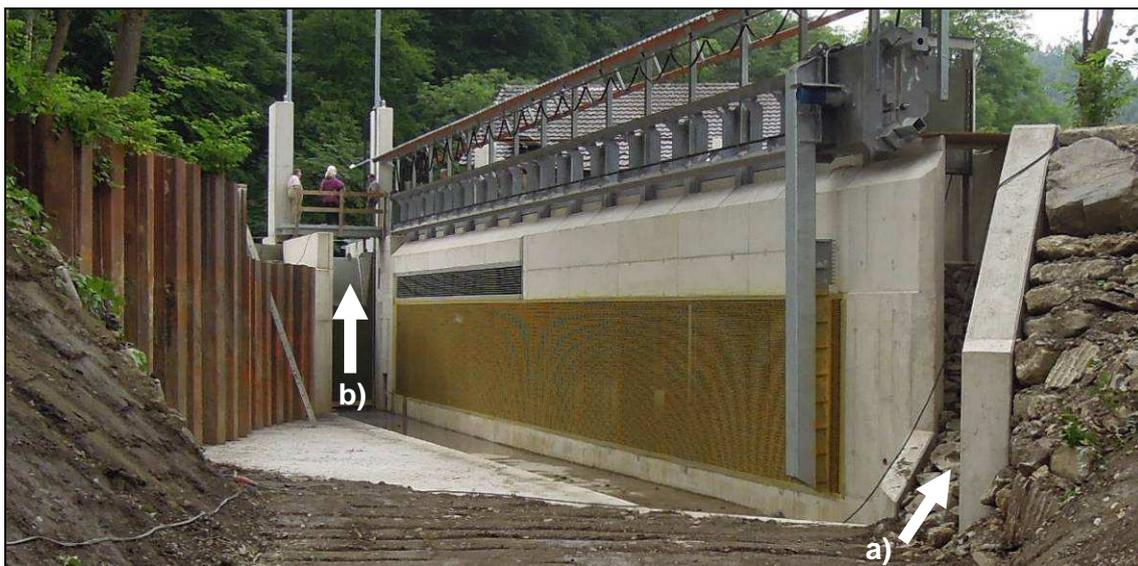
Abb. 48: Turbineneinlauf des Auer Kotten mit 12 mm-Rechen (gelb) sowie a) angeramp-tem Einlauf in den Schlitzpass und b) senkrecht aufragendem Spülschütz
