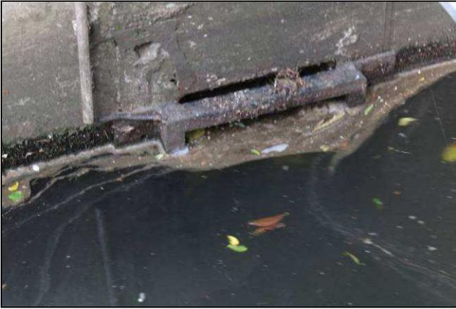
Abb. 6: Oberflächennahe Bypassöffnung am Krafthaus
