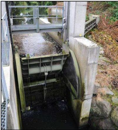
Abb. 8: Leerschuss mit Schwallklappe an der Wasserkraftanlage
