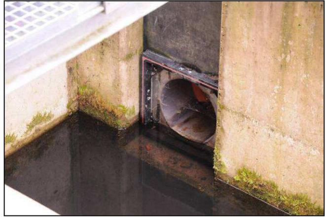
Abb. 7: Übergang vom sohlennahen Bypass ins Monitoringbecken in gelenktem Zustand
