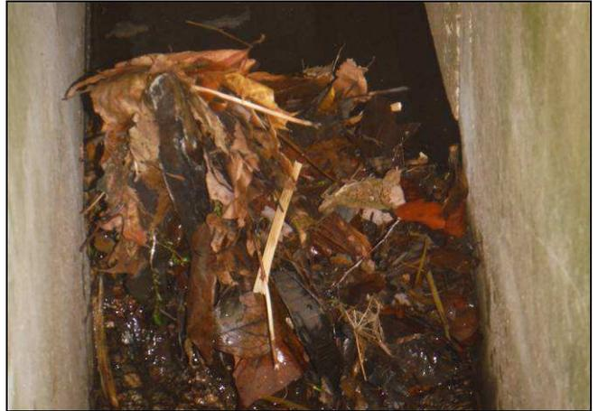
Abb. 47: Verklausung der Öffnung des oberflächennahen Bypasses im November 2016 vor (linkes Bild) und hinter der Öffnung (rechtes Bild)
