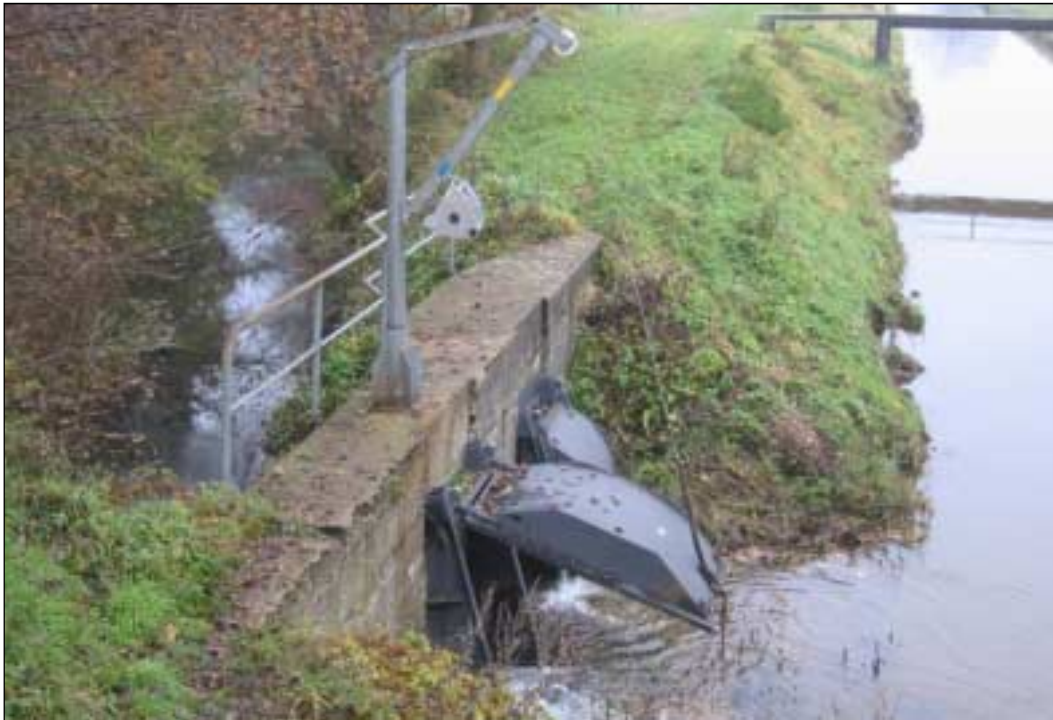
Abbildung 2: Klappe am Wolfsgraben vor der Einmündung in die Issel
