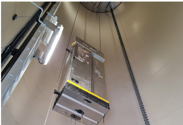
Befahranlage im Inneren des Windrades.
