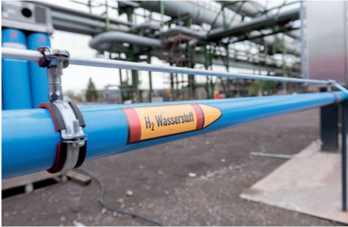
Wasserstoff-Versuchsanlage bei tkSE.
