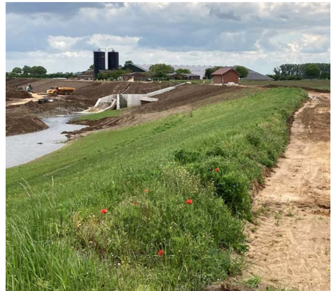
Die Deichbaustelle mit der neuen Fischaufstiegsanlage.
