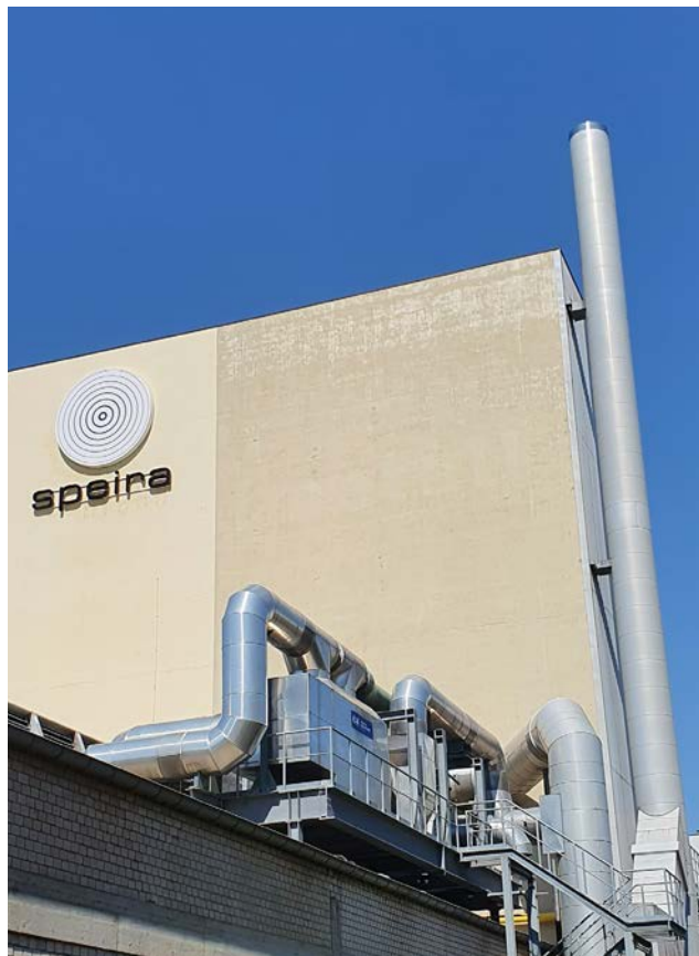
Sichtbarer letzter Teil der Apparate zur Reinigung der Abluftreinigung von den Glühöfen der Folienproduktion Serie 1 im Werk Grevenbroich Speira GmbH
