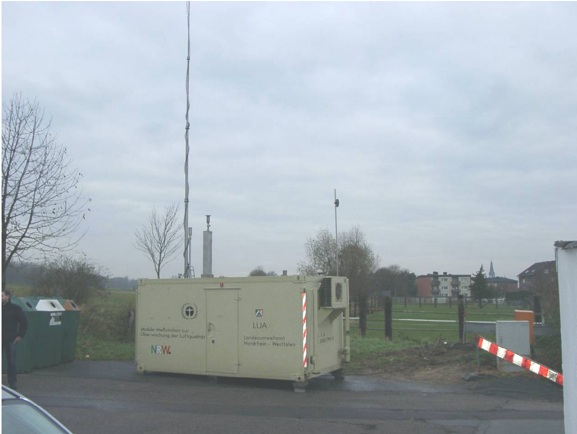
Abb. 2.2/1: Bild der Messstation in Grevenbroich Gustorf-Gindorf
