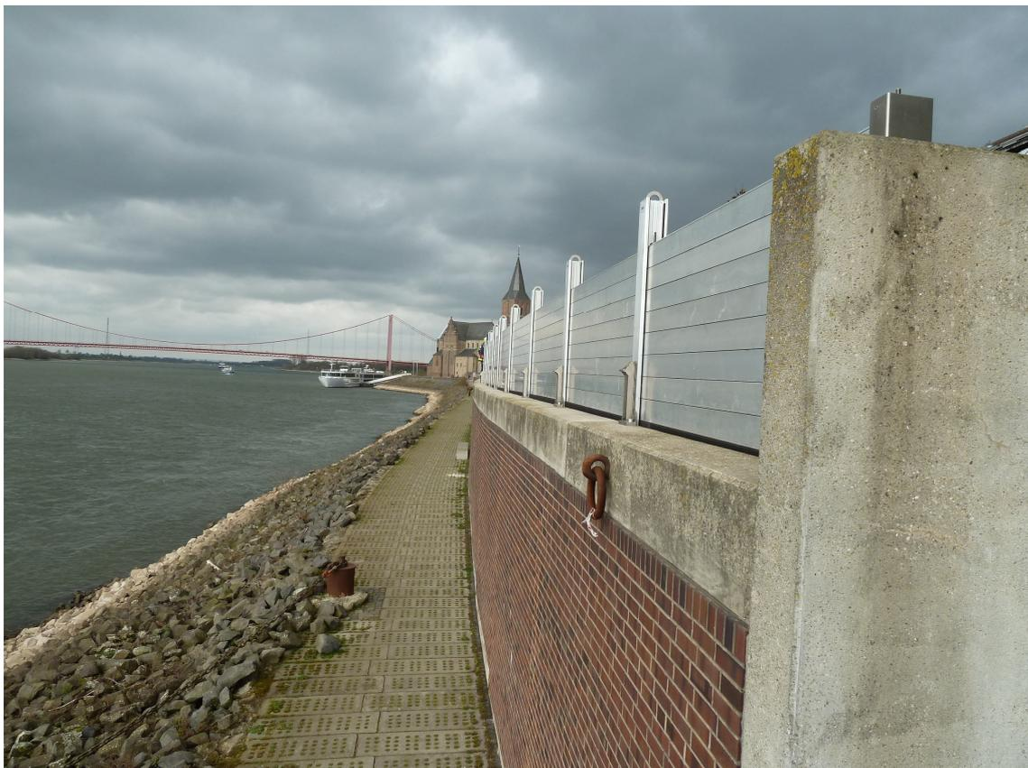
**Abb. 3.4:** Mobiles Hochwasserschutzelement nach Aufbau (Quelle: Bezirksregierung Düsseldorf)
