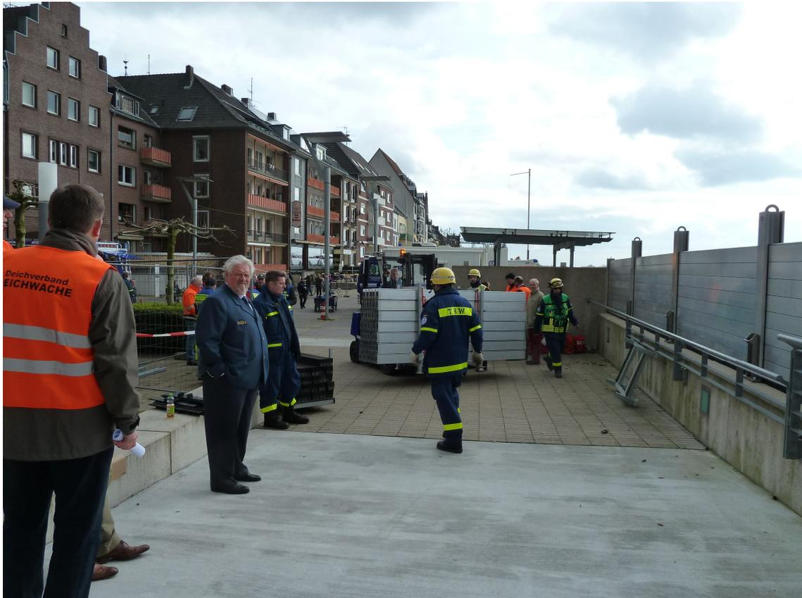
**Abb. 3.3:** Aufbau eines mobilen Hochwasserschutzelementes (Quelle: Bezirksregierung Düsseldorf)
