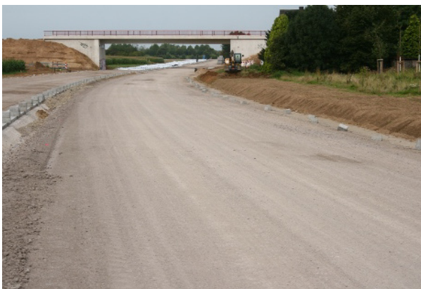
Abb. 2: Straßentrasse mit Brückenbauwerk
