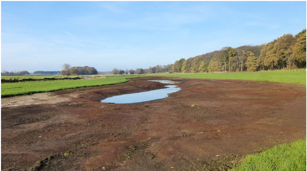
Abb. 1: Fläche an der Issumer Fleuth, kurz nach Umsetzung einer vorgezogenen Ausgleichsmaßnahme 1
