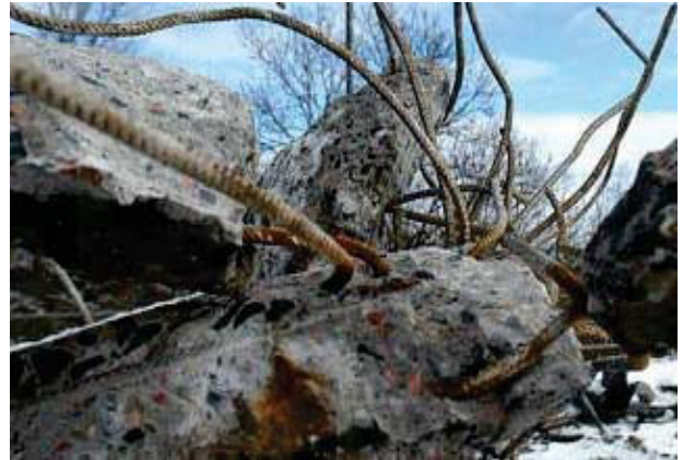
Stahlbeton nach der Vorzerkleinerung
