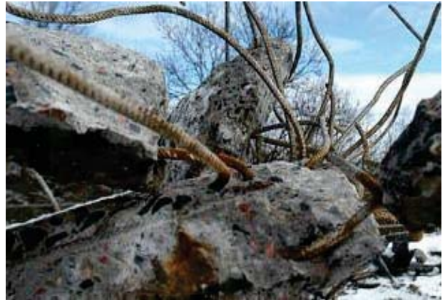
Stahlbeton nach der Vorzerkleinerung
