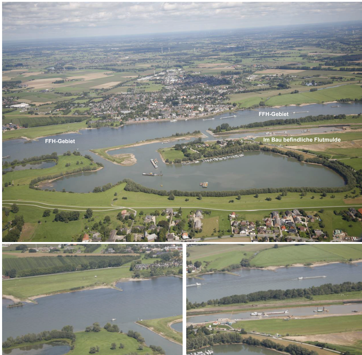
Abb. 2 Luftbildaufnahme, mit Sicht auf das Abgrabungsgewässer und die Bereiche des Rheins, die als Teilflächen dem FFH-Gebiet „Rhein-Fischschutzzonen zwischen Emmerich und Bad Honnef“ angehören (© aeropics.de)
