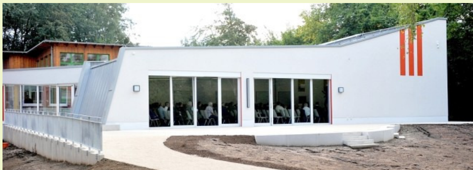
Gladbeck-Brauck, Bildungs- und Begegnungszentrum Anbau an ehemalige Schillerschule
