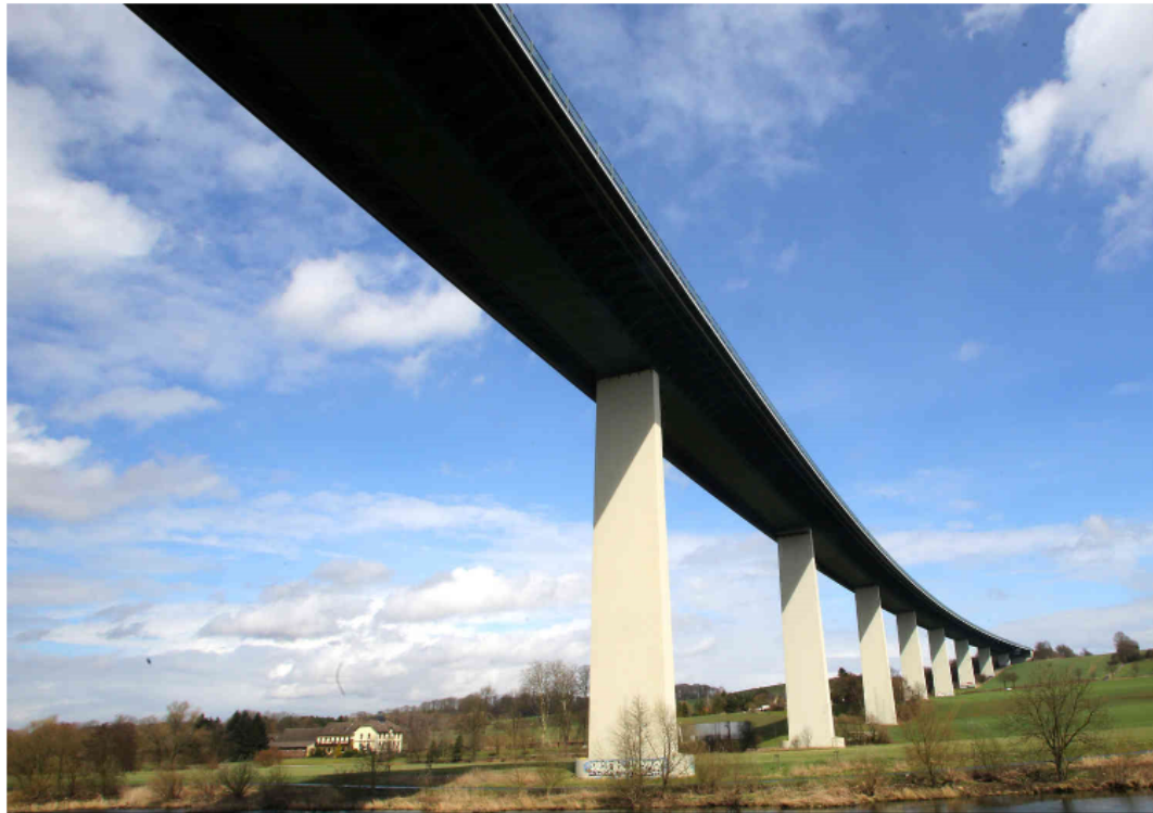
Die Ruhrtalbrücke, die Teil der Autobahn A 52 ist. Foto: dpa/Roland Wehrauch
